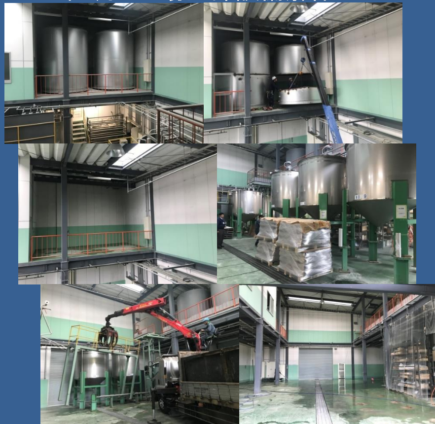
2018年6月 工場内部設備解体
